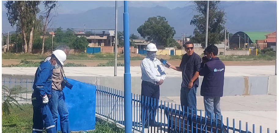
AETN inspecciona instalación eléctrica en la Plaza de la OTB La Joya
